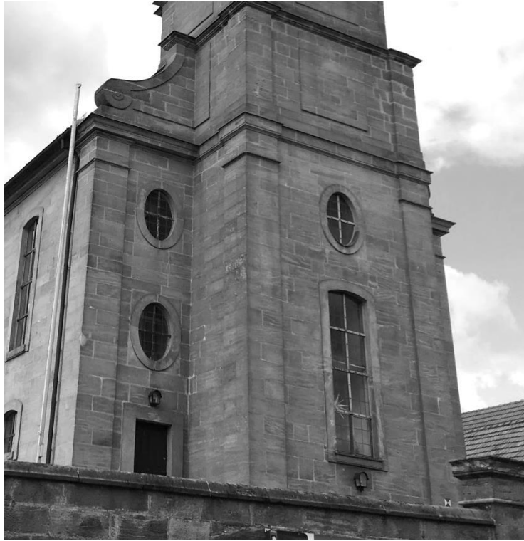
Vergleich unterer Kirchturm Heilgersdorf (1753-58, links) und Lahm (1728-32, rechts). Erdgeschoss mit glatten Ecklisenen, gleiche Geschosseinteilung, gleicher Übergang zum Kirchenschiff durch fast identische Voluten, gleiche Ovalfenster zur Belichtung der Treppenaufgänge zu den Emporen.
