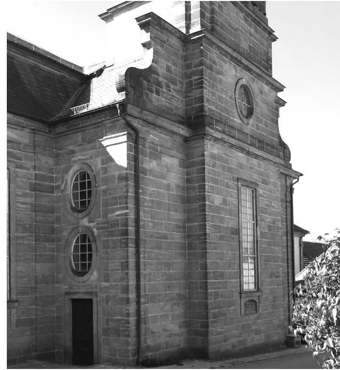
Vergleich unterer Kirchturm Heilgersdorf (1753-58, links) und Lahm (1728-32, rechts). Erdgeschoss mit glatten Ecklisenen, gleiche Geschosseinteilung, gleicher Übergang zum Kirchenschiff durch fast identische Voluten, gleiche Ovalfenster zur Belichtung der Treppenaufgänge zu den Emporen.
